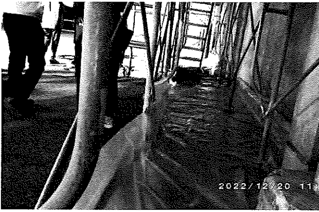
【⑪-2 ウォータージェット工法の床面養生】
