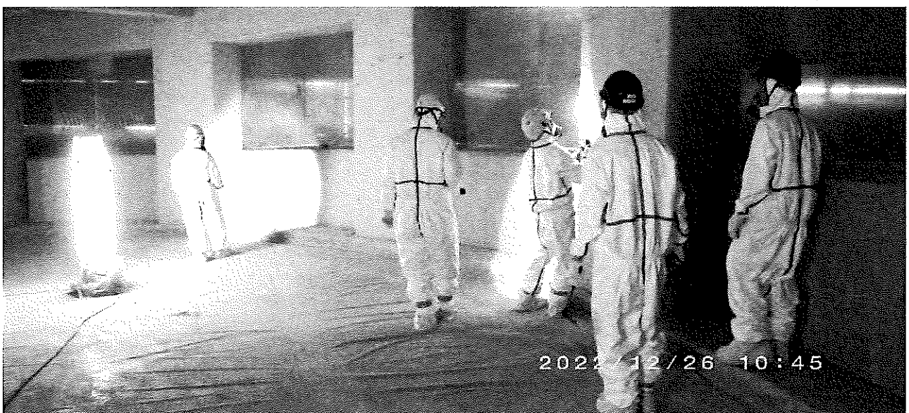
【⑰完了検査：壁塗材の除去の完了を検査する】
