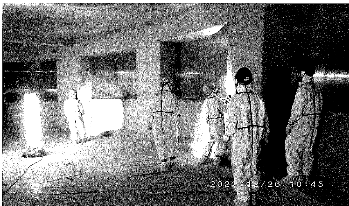
壁材の除去工事の完了検査をする
