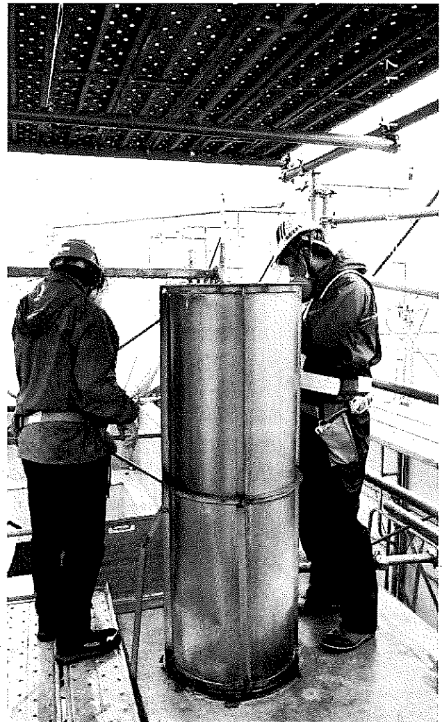
【⑧-2 煙突上部】
