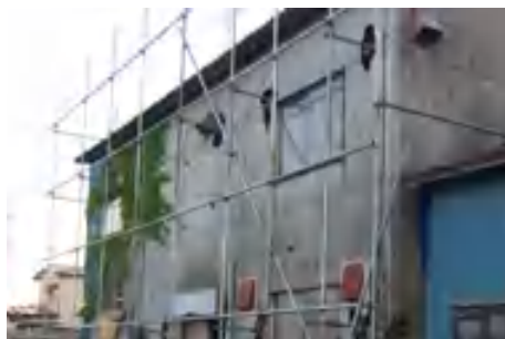
写真 3：波板スレートを破砕
