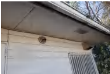
写真 25：住宅の外壁と軒天のサイディング
