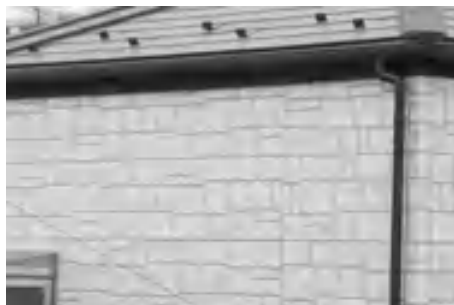
写真 26：外壁のサイディング
