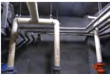
写真 3：吹付けアスベスト(クロシドライト)
