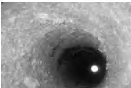
写真 13：頂部から見た煙突断熱材
