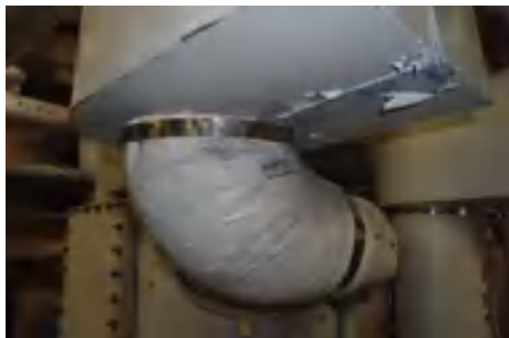
写真 14：配管保温材
