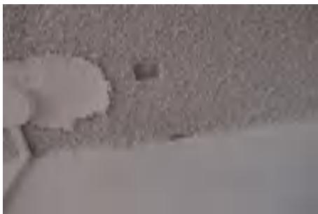
写真 9：吹付けパーライト
