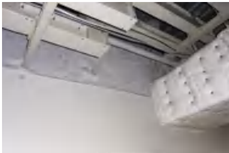
写真 6：湿式吹付けロックウール
