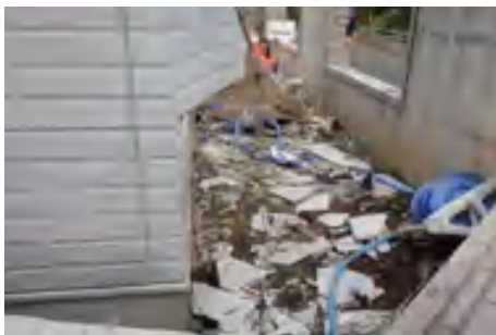
写真 2：外壁(サイディング)を重機で破砕
