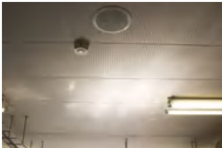
写真 23：内装のけい酸カルシウム板
