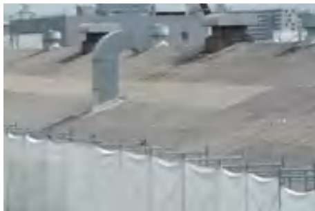
写真 17：工場の屋根のスレート波板
