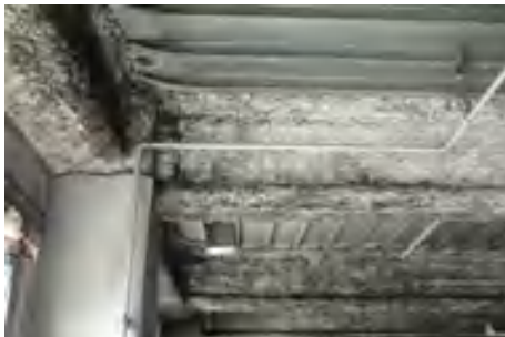
写真 5：吹付けロックウール
