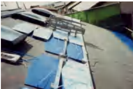
写真 20：施工中の住宅屋根用化粧スレート
