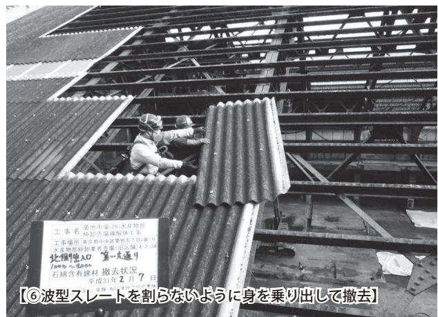
【⑤波形スレート屋根の手ばらしの様子】
