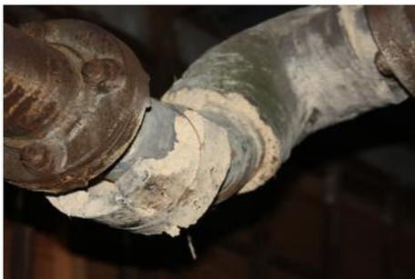
写真 15：劣化した配管保温材
