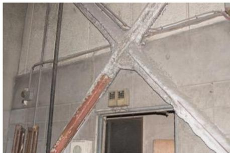
写真2：吹付けアスベスト(クリソタイル)
