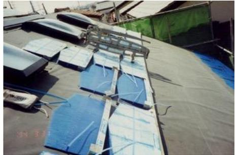
写真 20：施工中の住宅屋根用化粧スレート
