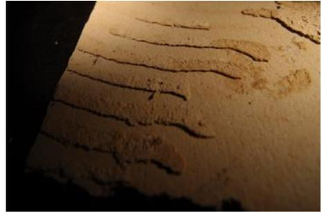
写真 32：裏面の接着剤に石綿含有
