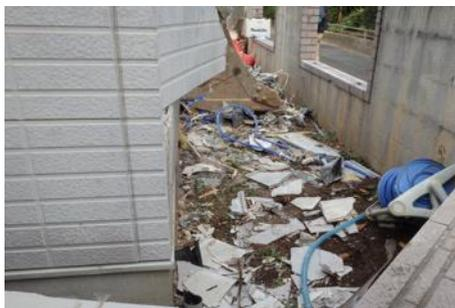
写真2：外壁(サイディング)を重機で破砕
