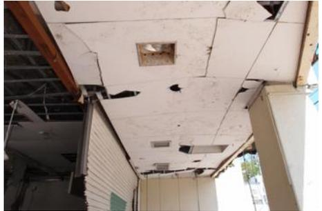
写真 24：被災した軒天のけい酸カルシウム板
