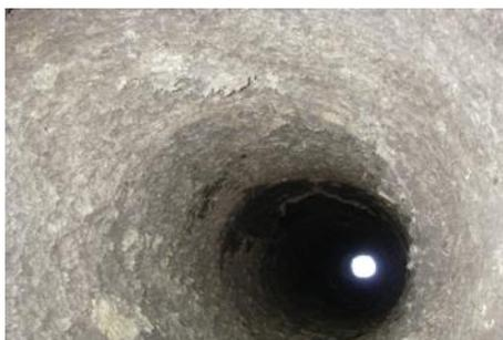
写真 13：頂部から見た煙突断熱材
