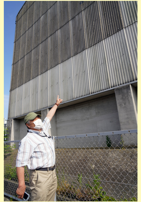
石巻でのアスベスト調査
