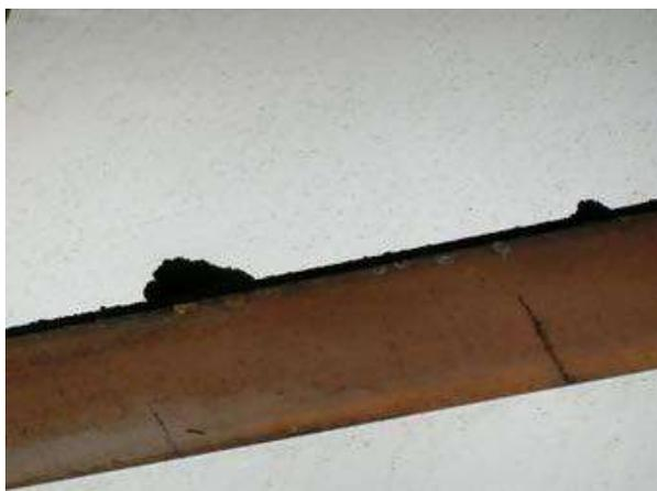
鉄骨の上に残った吹付け材の残骸
