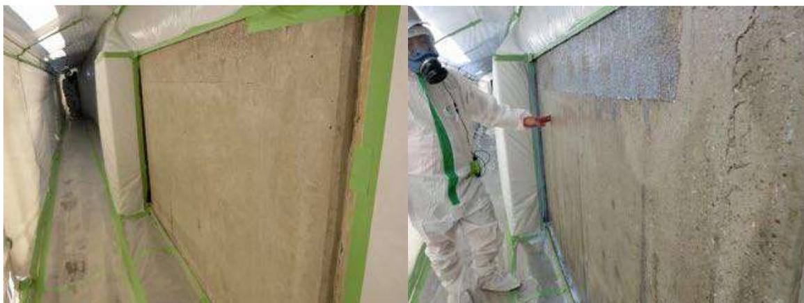
石綿含有の下地材が残った状態 → 下地材を除去した状態
