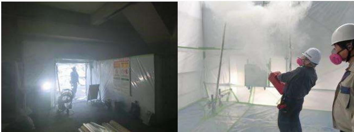
養生からのスモークの漏れで、養生外で煙が確認された
