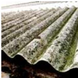
写真 18：劣化したスレート波板
