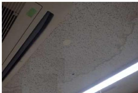
写真 27：ロックウール吸音天井板
