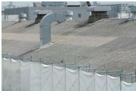
写真 17：工場の屋根のスレート波板
