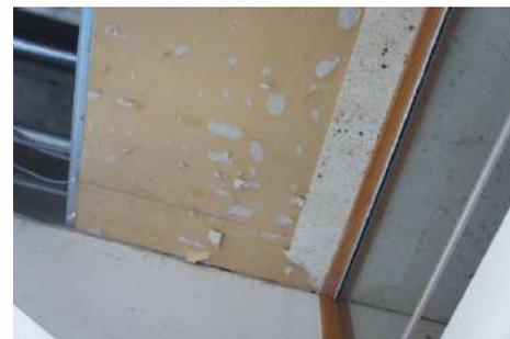
写真 28：水害で被災したロックウール天井
