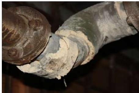
写真 15：劣化した配管保温材
