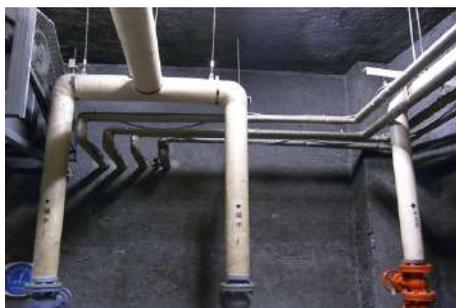
写真3：吹付けアスベスト(クロシドライト)
