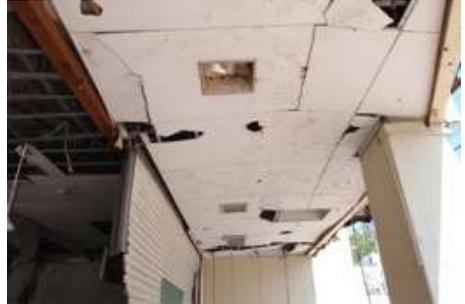
写真 24：被災した軒天のけい酸カルシウム板
