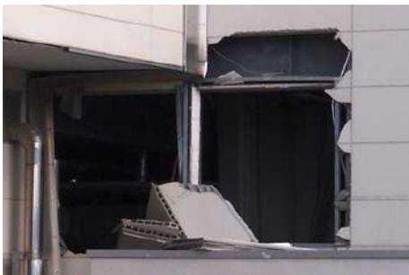
写真 21：津波で被災した押出成形板
