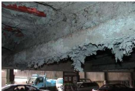
写真1：吹付けアスベスト(クロシドライト)
